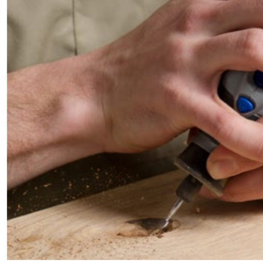
Preparazione dei nodi per la stuccatura
